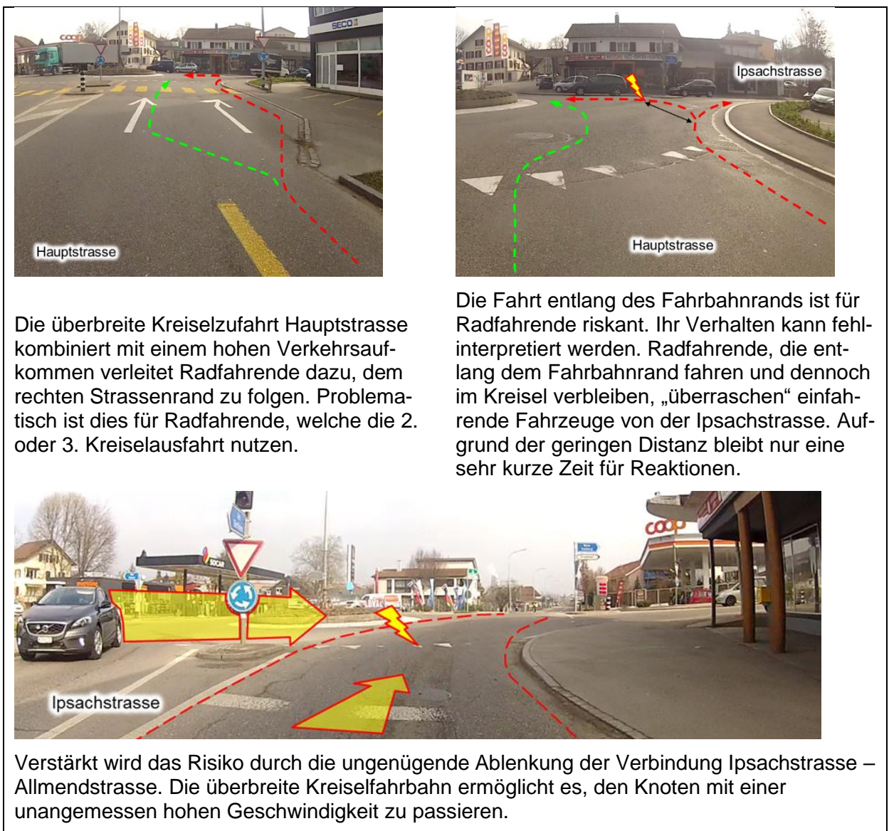
Abbildung 6: Mängel der best. Anlage: Einfahrt Hauptstr., Ablenkungswinkel Ipsachstr.
